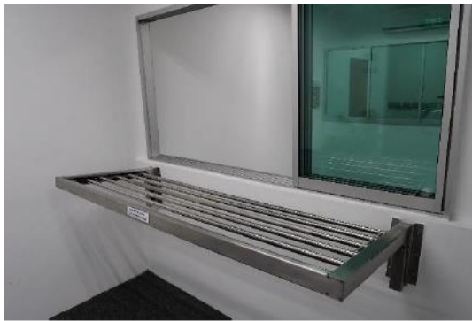
伸缩式晾衣架的晾衣杆可在框架内沿轨道向外伸展（左图），并在悬挂或收取衣物时缩回（右图）
